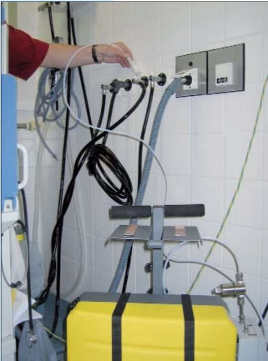
Dichtheitskontrolle eines Wandauslasses
